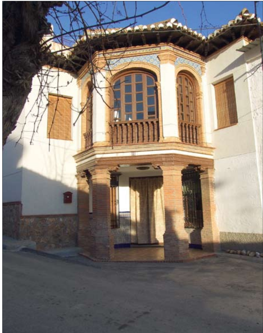
Balconada construida en 1934
